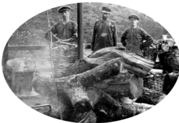
Vänster. Träkolanläggning på Skånska Ättiksfabriken.
